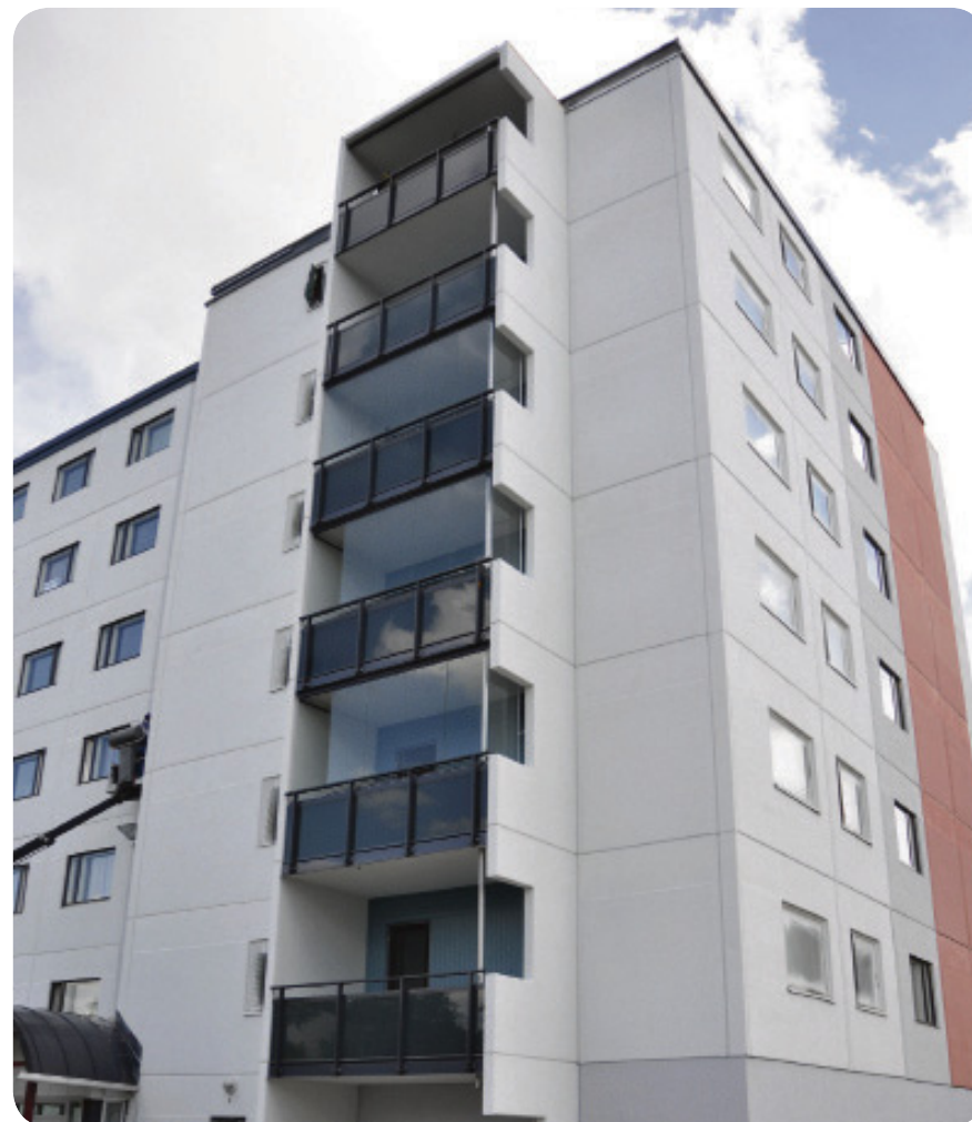
Sauvakatu 6:n julkisivuremontti on loppusuoralla.
