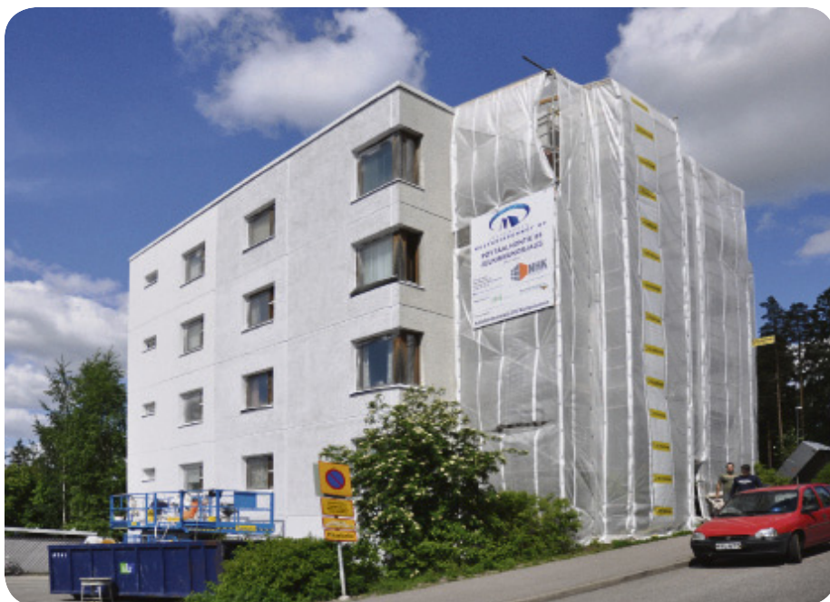
Pöytäalhontie 95:n Mestarikiinteistö saa kesän aikana uuden ilmeen julkisivuremontin myötä.
