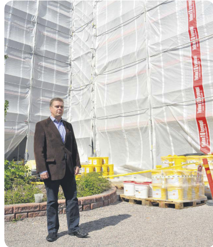
NHK Rakennus Oy:llä on käynnissä Pöytäalhontie 97:n julkisivuremontti. Remontti valmistuu lokakuussa. Kuvassa NHK Rakennus Oy:n julkisivuyksikön johtaja Jukka-Pekka Soila.
